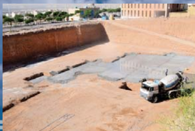
پایان بتن ریزی، بهمن ماه ۱۳۹۴
